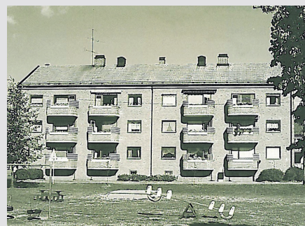
DBBLs første boligblokker ble reist i Lærums gate 1 og 3 på Bangeløkka i 1949. Husene er tegnet av byarkitekt Gulden etter forbilde av kommunens blokker på Sørbyløkka
